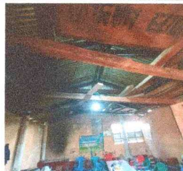
Foto 2: Ésta imagen muestra que las reglas de maderas se sustituyan por tubos galvanizados con medidas de 2"x2"
