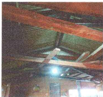
Foto 1: En la imagen se aprecia maderas a sustituir por tubos de metal 2"x6". de igual manera la sustitución de lámina por lámina troquelada.
