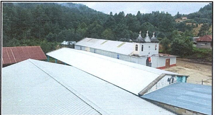
Foto 1.2: Sustitución de láminas, por láminas troqueladas
