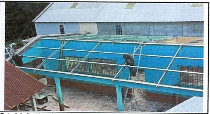
Foto 2.2: Sustitución de soporte de madera, por soporte de metal
