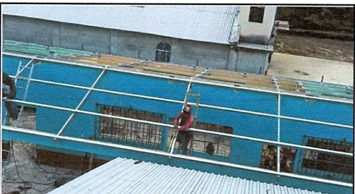
Foto 2.1: Sustitución de soporte de madera, por soporte de metal
