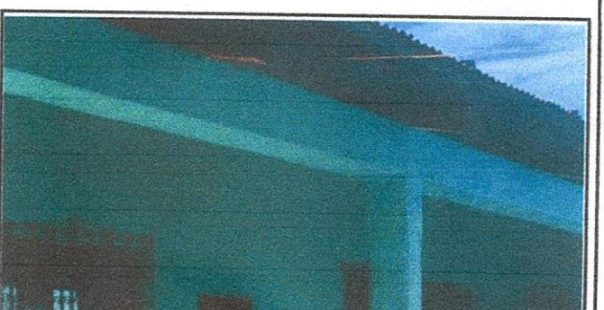
Foto 2.3: Sustitución de soporte de madera, por soporte de metal
