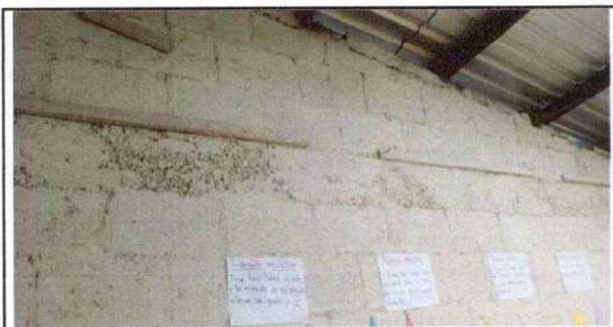
Foto 5: Pintura en muros exteriores e interiores
