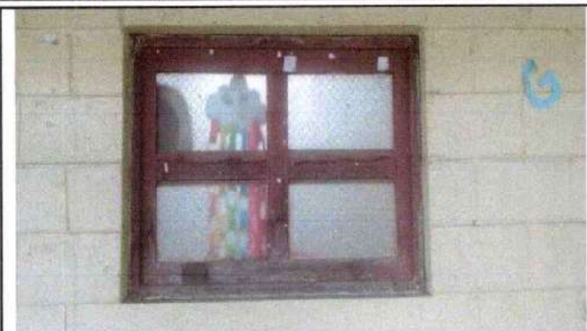
Foto1: Sustrución de ventanas de madera por metal mas vidrio de 1.25 x 0.88 metros
