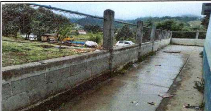
Foto 1: Repello en muro perimetral del modulo II
