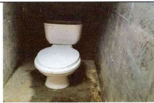
Foto 6: Sustrución de inodoros
