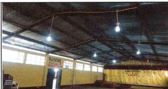
Foto 5: Sustitución de focos ahorradores
