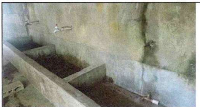
Foto 6: Sustitución de llave de choro
