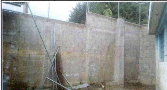
Foto 2: Repello en muro perimetral del modulo III
