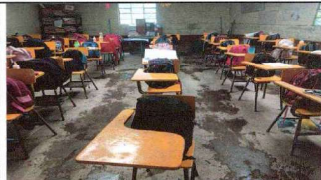
Foto 4: Mejoramiento de piso de torta de concreto por piso de granito
