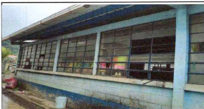
Foto 3: Sustrución de vidrios 45 X 18 centímetros
