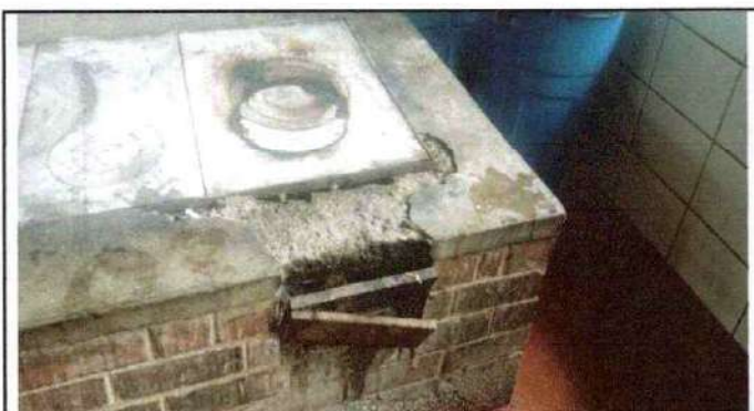
Foto 3: Reparación de estufa rural
