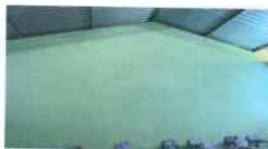
Foto 8: Repello de paredes
