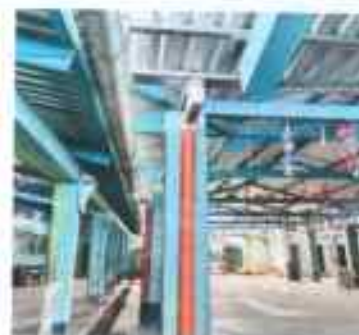
Foto 6: Sustitución de bajada de agua pluvial por tubo PVC3"
