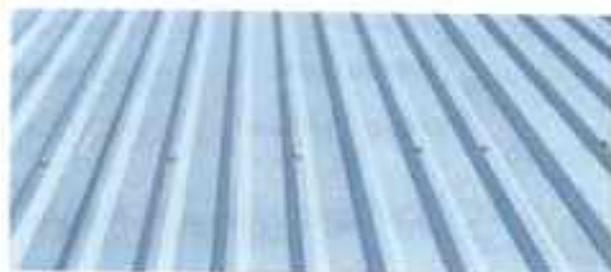
Foto 3: Sustitución de elementos de fijación
