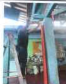
Foto 6: Sustitución de bajada de agua pluvial por tubo PVC3"
