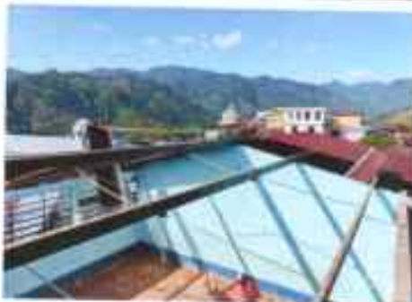
Foto 1: Sustitución de lámina, por lamina troquelada aluzinc calibre 26
