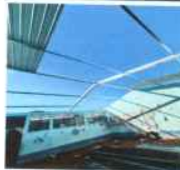
Foto 2: Sustitución de capote de lámina para lamina troquelada
