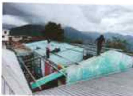
Foto 3: Sustitución de elementos de fijación
