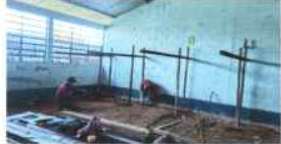
Foto 8: Repello de paredes
