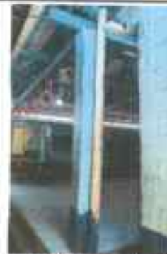
Foto 6: Sustitución de bajada de agua pluvial por tubo PVC 3"
