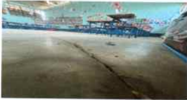
Foto 7: Sustrucción de torta de cemento por piso de granito
