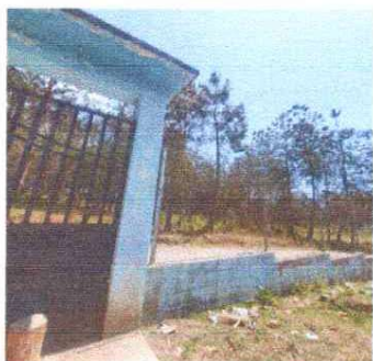
Foto 3: Aplicación de pintura en muro de contencion
