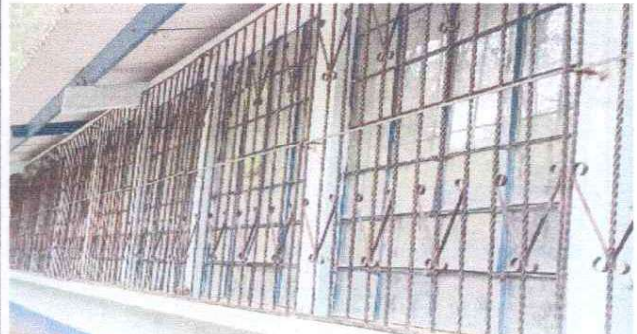
Foto 10: Mantenimiento a balcones de metal
