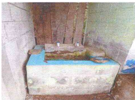
Foto 9: Sustitución de lava manos
