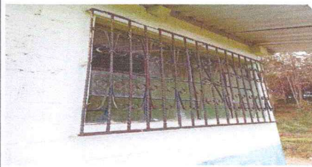
Foto 8: Sustitución de vidrios
