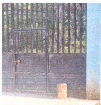
Foto 5: Reparacion de porton de entra principal del centro educativo
