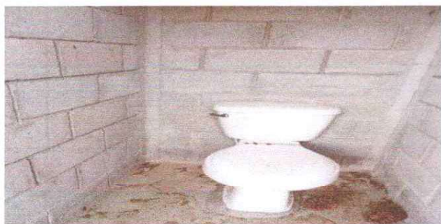
Foto 11: Sustitucion de accesorios inodoro.
