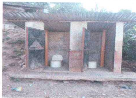
Foto 8: Sustrución de piso de granito
