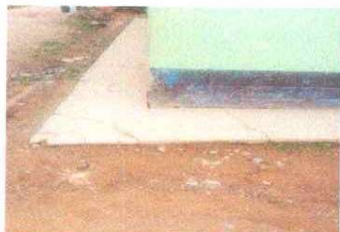
Foto 7: Sustrución de banquetta
