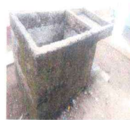
Foto 4: Sustitución de lavamanos
