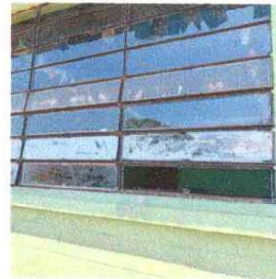
Foto 2: Ventanas; Sustitución de vidrios
