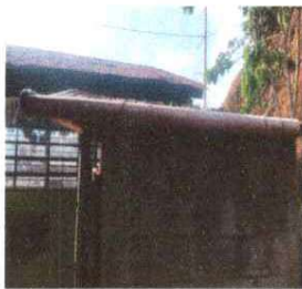
Foto 3: Sustitución de canal de pvc
