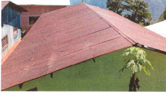
Foto1: Sustitución de lamina.
