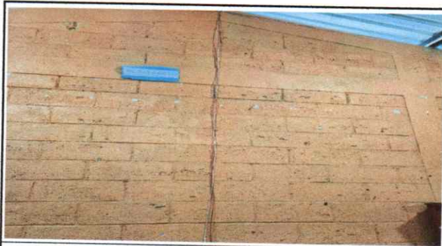
Foto 9: Reparación de cableado eléctrico
