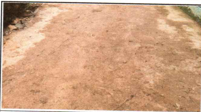
Foto 4: Sustitución de piso de torta de concreto
