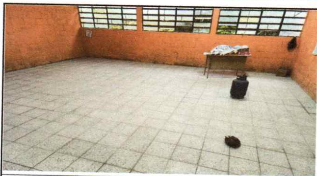
Foto 3: Sustitución de piso de granito
