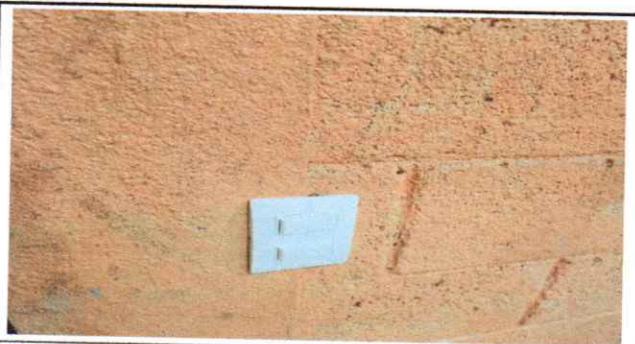
Foto 11: Sustrucción de apagadores dobles
