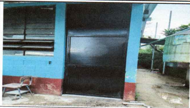
Foto 1: Mantenimiento a estructura (lijado, cepillado, aplicación de pintura)
