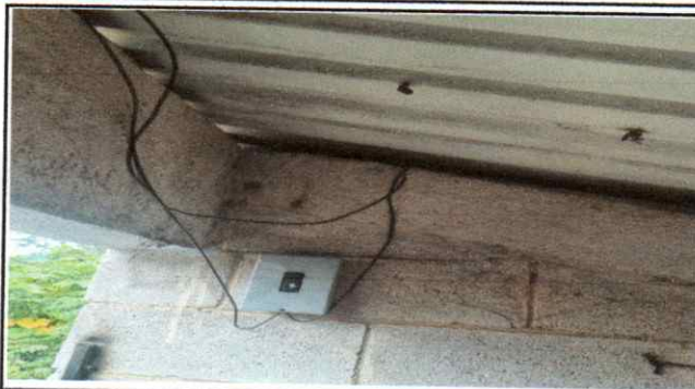
Foto 8: Sustrucción de flipones
