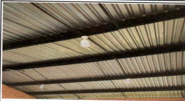
Foto 7: Sustrucción de plafoneras
