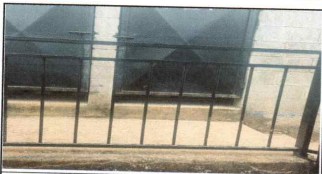
Foto 5: Sustitución de barandas de metal
