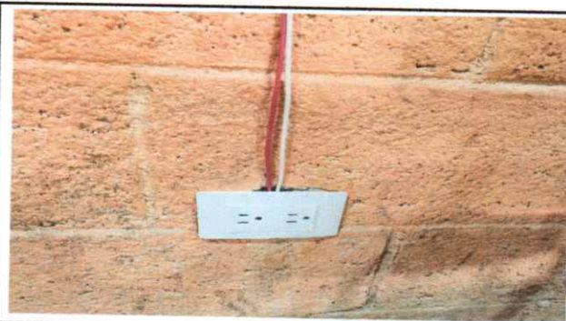
Foto 10: Sustrucción de tomacorrientes dobles
