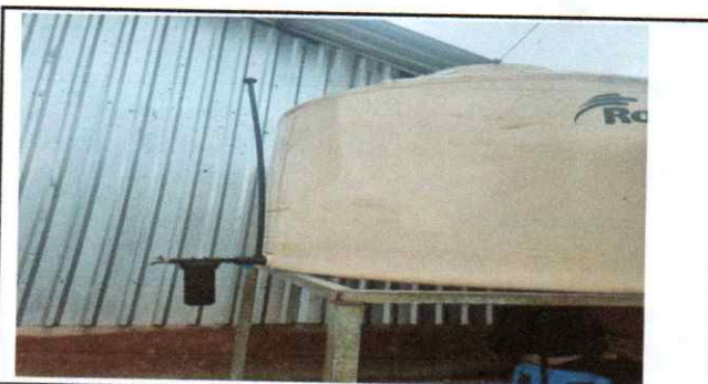
Foto 12: Sustrucción de depósito de agua 1700 lt
