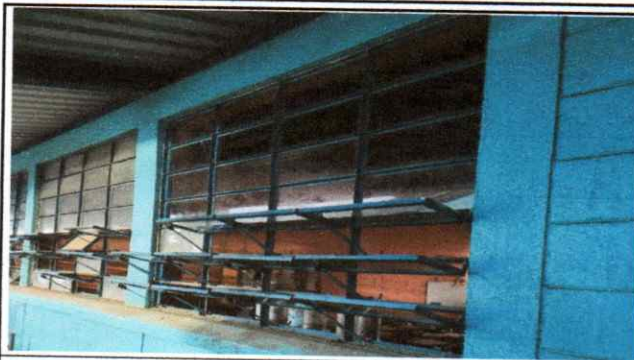
Foto 2: Sustitución de vidrios
