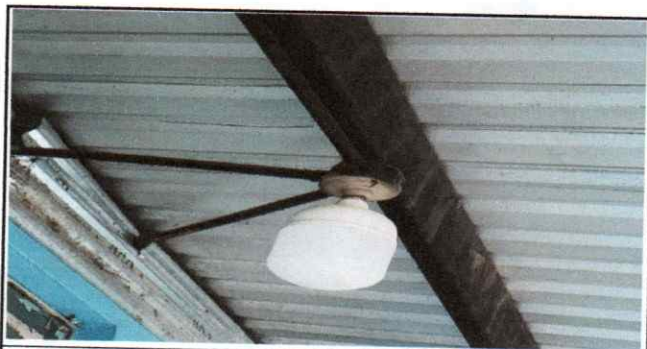
Foto 6: Sustitución de focos ahorradores
