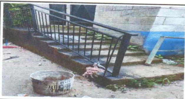
Foto 5: Sustitución de barandas de metal
