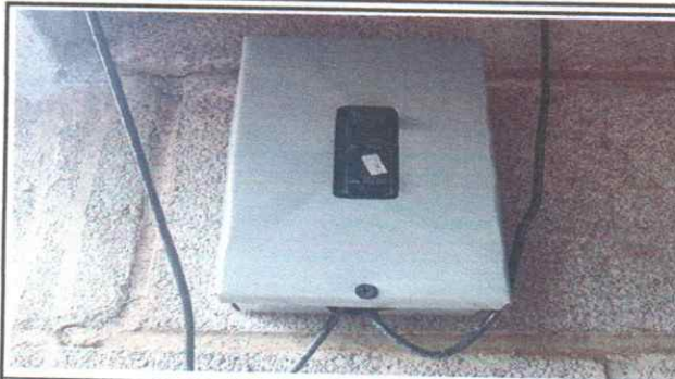
Foto 8: Sustitución de flipones
