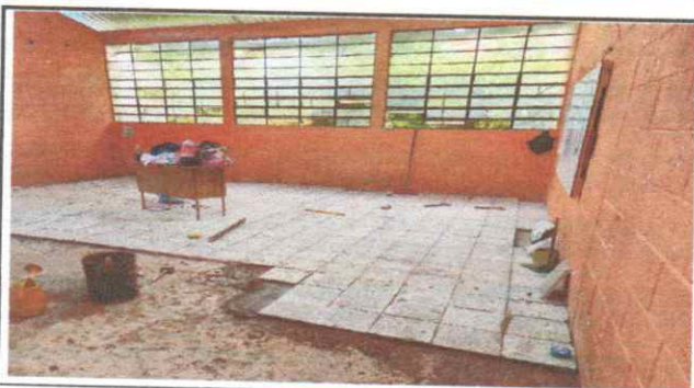
Foto 3: Sustitución de piso de granito
