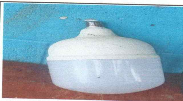
Foto 6: Sustitución de focos ahorradores
