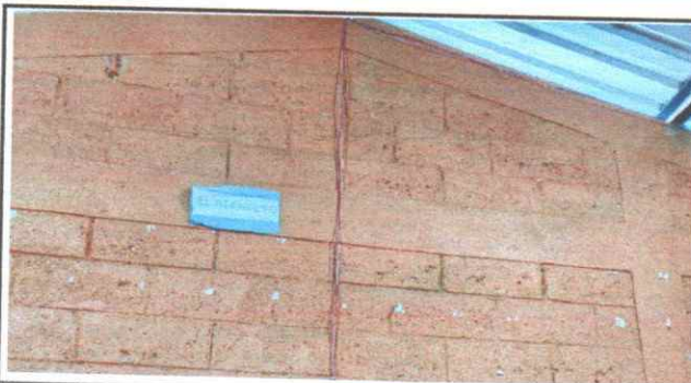
Foto 9: Reparación de cableado eléctrico
