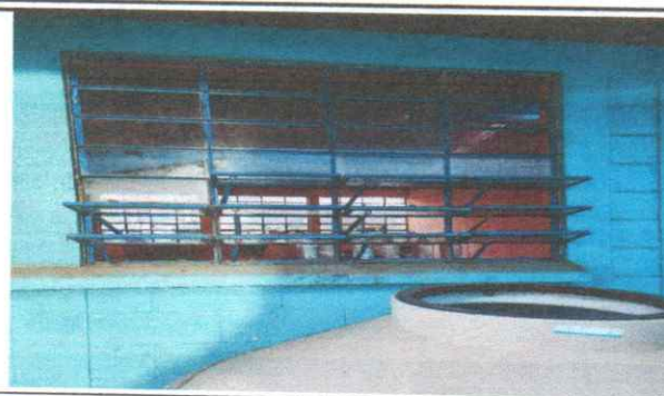
Foto 2: Sustitución de vidrios
