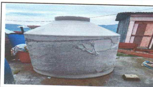
Foto 12: Sustitución de depósito de agua 1700 lt
