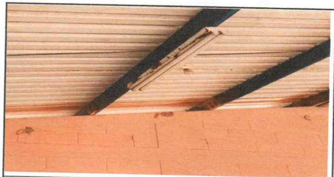
Foto 6: Sustitución de focos ahorradores
