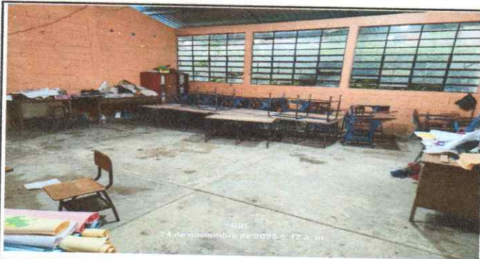
Foto 3: Sustitución de piso de granito
