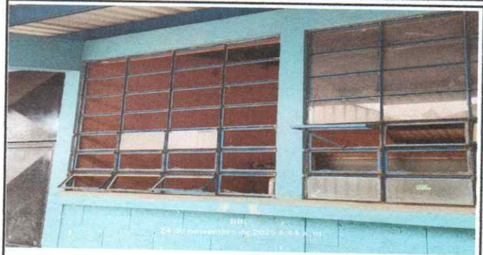
Foto 2: Sustitución de vidrios
