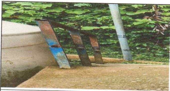
Foto 5: Sustitución de barandas de metal
