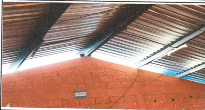
Foto 7: Sustrucción de plafoneras
