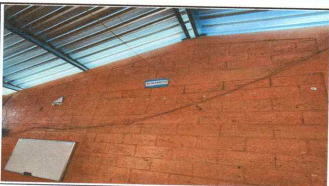
Foto 9: Reparación de cableado electrico
