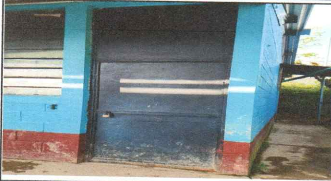
Foto1: Mantenimiento a estructura (lijado, cepillado, aplicación de pintura)
