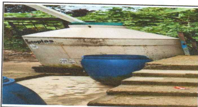
Foto 12: Sustrucción de deposito de agua 1700 lt
