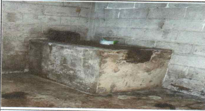
Foto 13: Sustrucción de estufa rural (completa) incluye chimenea y plancha de metal
