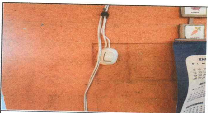
Foto 11: Sustrucción de apagadores dobles
