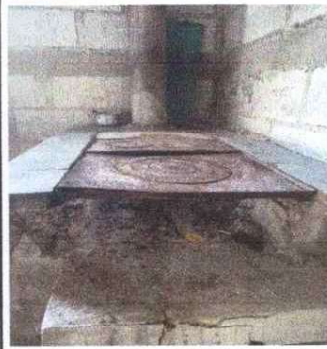
Foto 4: Sustitución de estufa rural (completa) incluye chimenea y plancha de metal y pila de cemento de un lavadero
