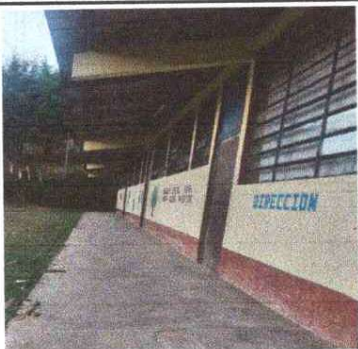
Foto7: Sustrucción de canal de pvc de 6 mts pluvial color blanco
