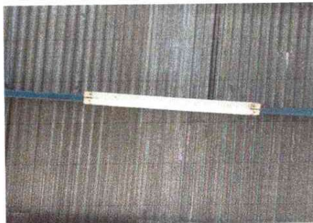
Foto 8: Reparación de sistema eléctrico
