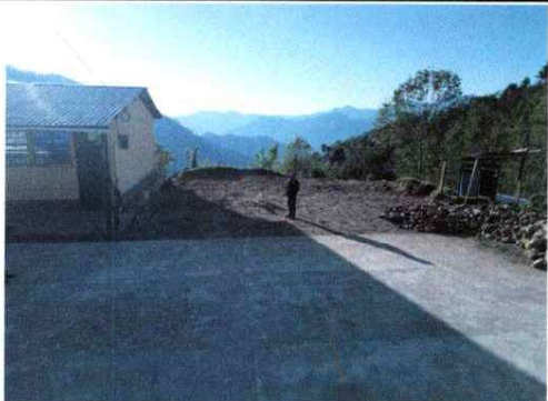
Foto1: Mejoramiento de piso de granito
