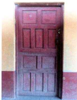
Foto 3: Sustitución de puerta de madera, por metal
