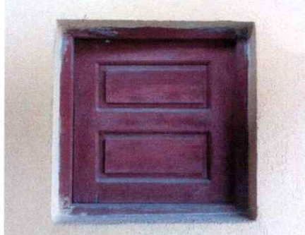
Foto 4: Sustitución de ventana de madera, por metal
