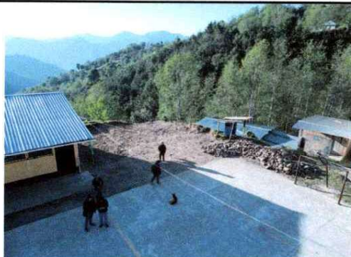
Foto 2: Mejoramiento de láminas troqueladas y estructura de techo
