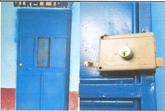
Foto 3: Mantenimiento a estructura 1 X 2.10 metros
