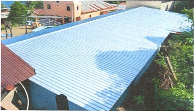
Foto1.1: Sustitución de lámina, por lámina troquelada aluzinc calibre 26
