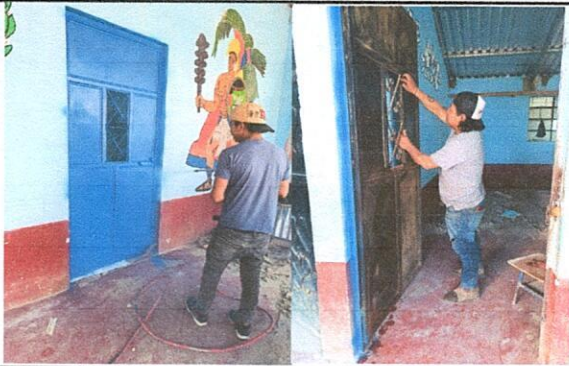
Foto 3: Mantenimiento a estructura 1 X 2.10 metros
