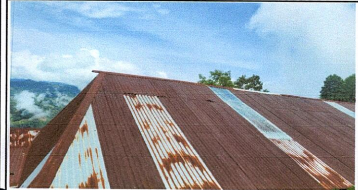
Foto1.1: Sustitución de lámina, por lámina troquelada aluzinc calibre 26
