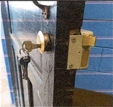
Foto 7: Sustitución de chapas de puertas
