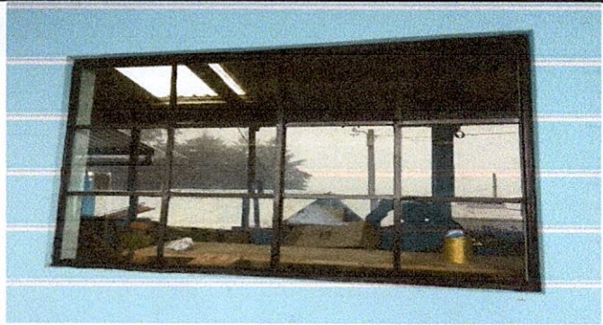
Foto 5.1: Sustitución de ventanas por ventanas corredizos de metal
