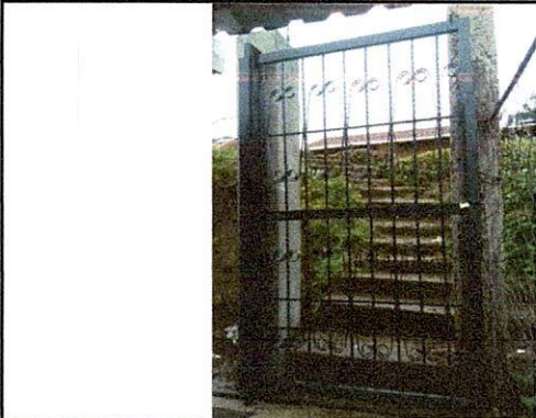
Foto6: Sustitución por un porton de metal
