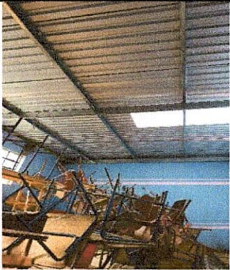
Foto 2: Estructura de techo
