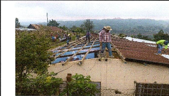
Foto1: Cubiertas de láminas
