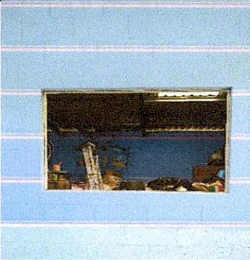
Foto 5.1: Sustitución de ventanas por ventanas corredizos de metal
