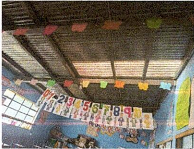
Foto 2: Estructura de techo
