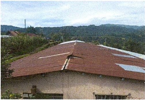
Foto1: Cubiertas de láminas
