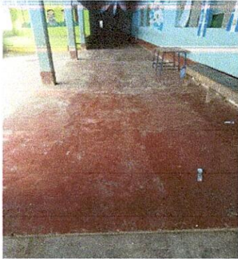
Foto 4: Sustitución de piso de torta de cemento
