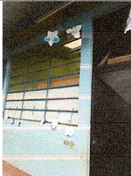
Foto 5.2: Instalación de balcones
