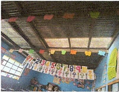
Foto 2: Estructura de techo
