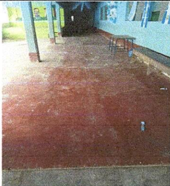
Foto 4: Sustitución de piso de torta de cemento
