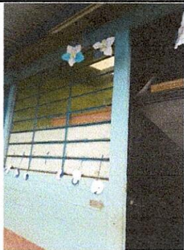
Foto 5.2: Instalación de balcones
