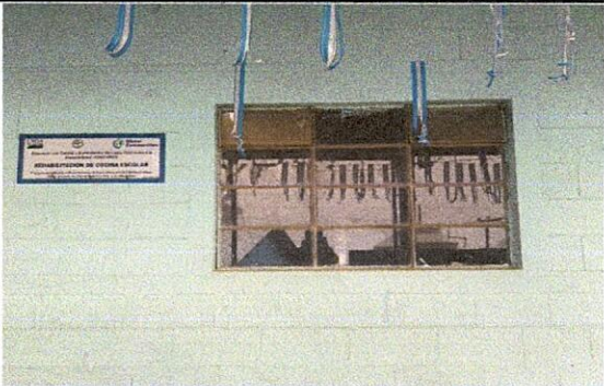
Foto 5.1: Sustitución de ventanas por ventanas corredizos de metal
