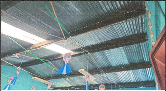
Foto 2: Mantenimiento a estructura de soporte de metal
