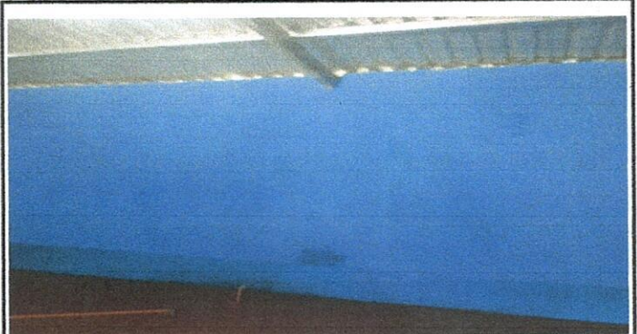
Foto 4: muro pintado y terminada.
