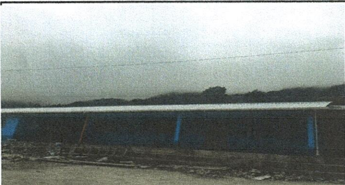
Foto 3: parte de en frente ya cuenta con canal y bajada de agua terminada.
