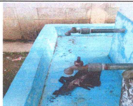
Foto 6: Sustitución de llave de chorro de metal, por metal
