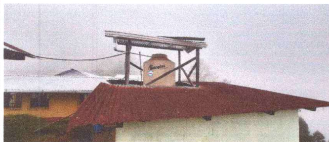
Foto1: Sustitución de lámina, por lámina troquelada
