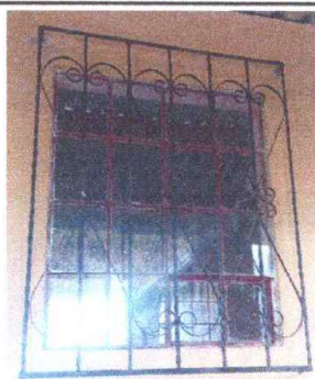
Foto 3: Mantenimiento a balcones de metal
