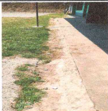
Foto 3: Mantenimiento de cuneta
