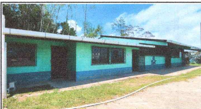
Foto 4: Aplicación de pintura interior y exterior
