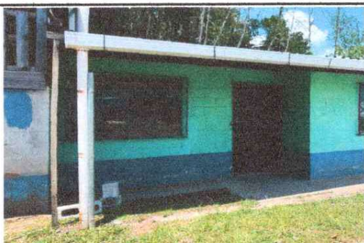
Foto 5: Instalación de Rotoplas de 750 litros
