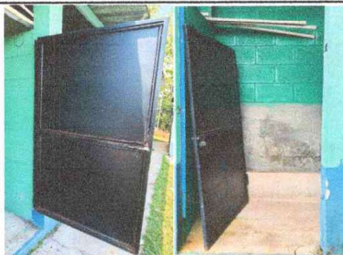
Foto 1: Mantenimiento de estructura y sustitución de puerta
