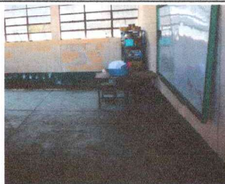
Foto 2: Sustitución de piso de concreto, por piso de granito (interior y corredor) aula y cocina
