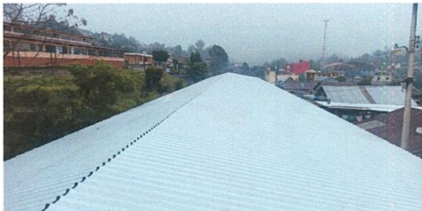
Foto 6: Sustitucion de laminas
