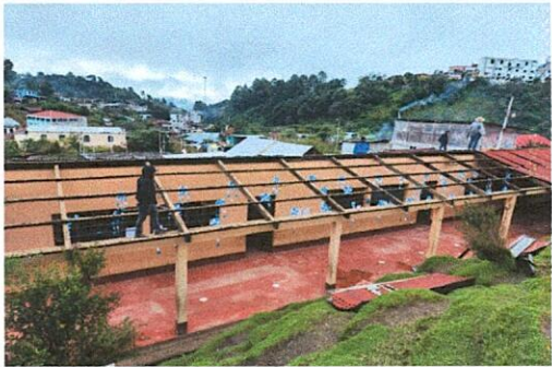
Foto 2: Cambio de laminas
