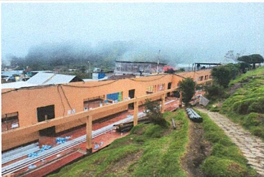
Foto 6: Sustitucion de laminas
