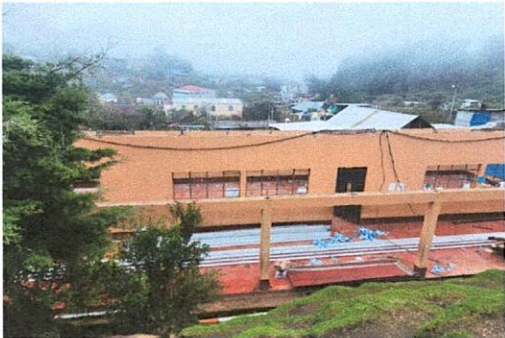
Foto 5: Sustitucion de laminas
