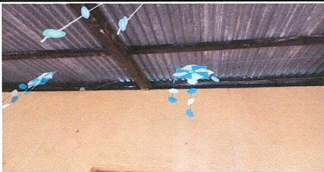
Foto 5: Sustitucion de laminas
