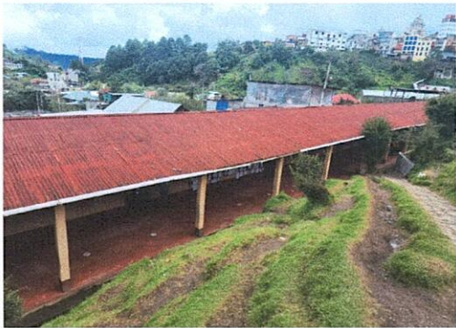
Foto1: Cambio de láminas
