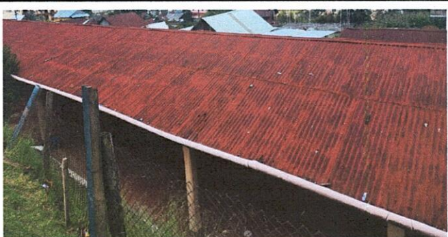
Foto 6: Sustitucion de laminas
