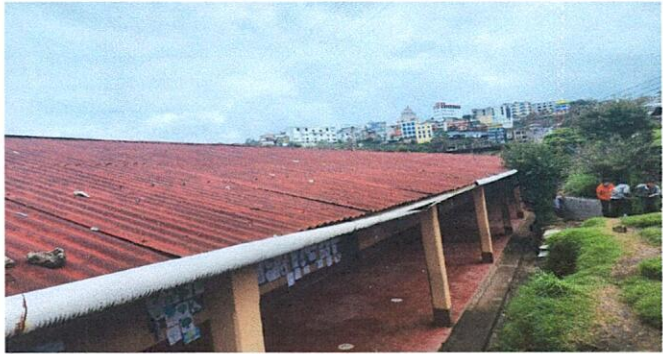
Foto 2: Cambio de laminas
