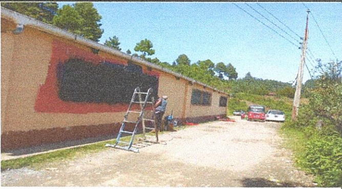
Se aprecia pintada de los balcones del módulo 1
