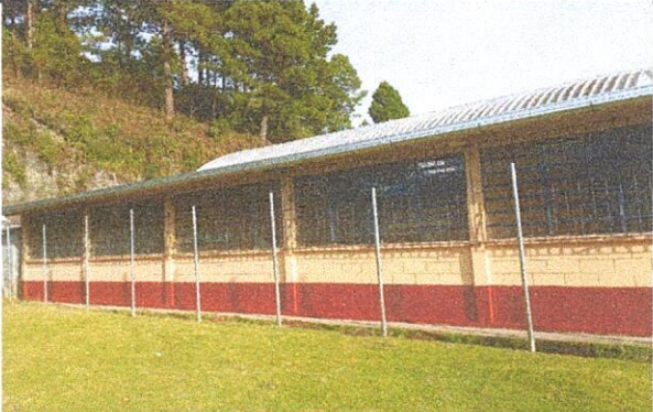
Foto 3: se aprecia la instalación de canal de agua pluvial y la instalación de tubos hg's para malla.
