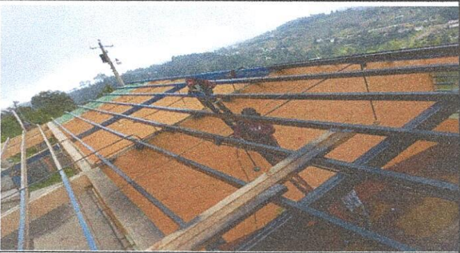
Foto 5: Mantenimiento de estructura de techos de metal.
