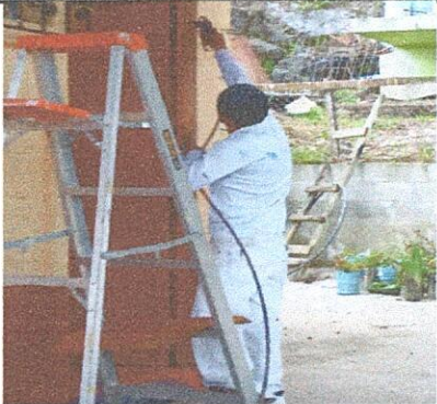
Se aprecia el mantenimiento de puertas.
