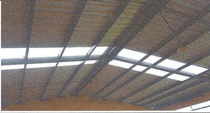
Foto 6: Instalación de láminas troqueladas en la parte interna del centro educativo
