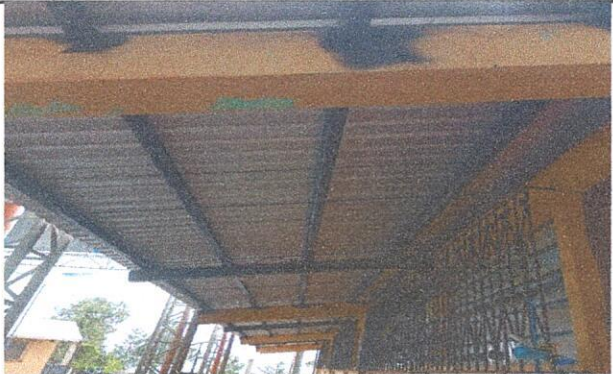
Instalación de lámina troqueladas y mantenimiento de costaneras.
