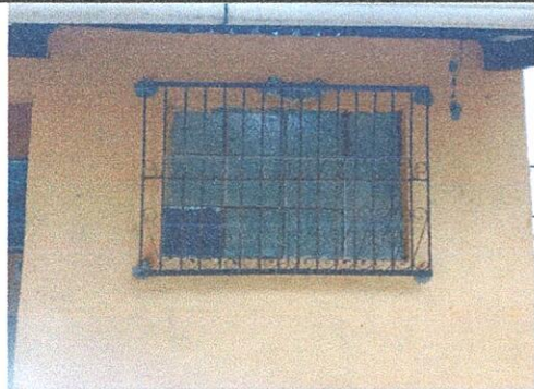
Foto 6: Mantenimiento de balcones del módulo 2 del centro educativo
