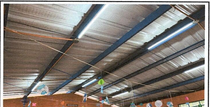
Foto 6: cableado electrónico finalizado.
