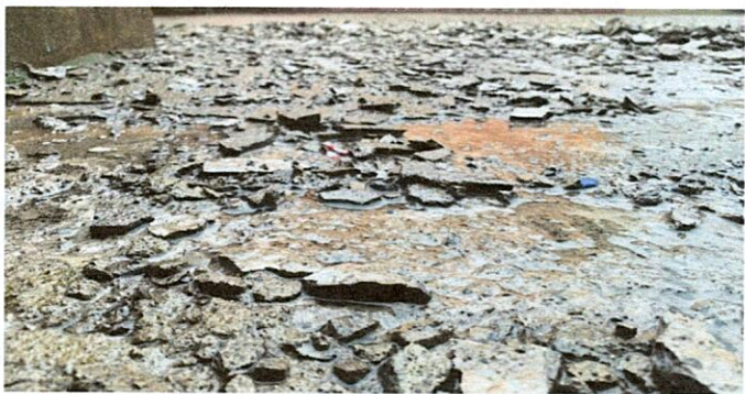
Foto 4: piso de torta en proceso.
