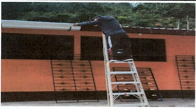
Foto 3: canal en proceso.
