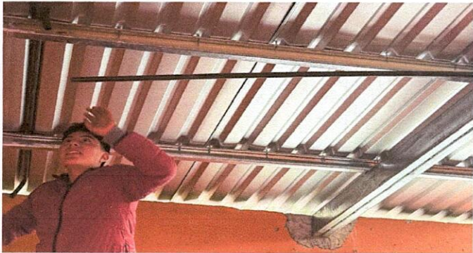
Foto1: Ducto electrico y accesorios en proceso.
