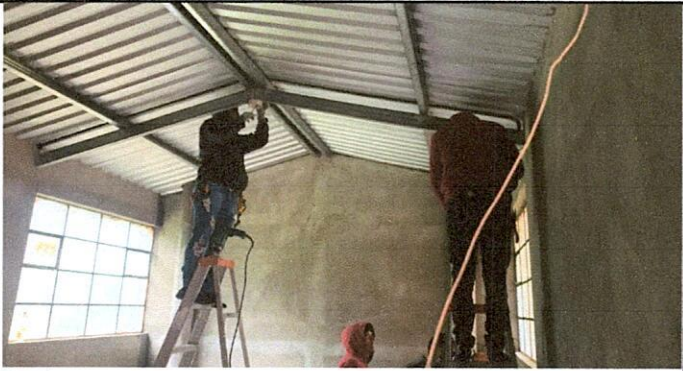
Foto1: plafoneras en proceso.
