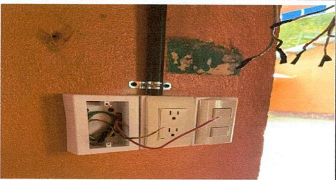
Foto 3: tomacorrientes en proceso.
