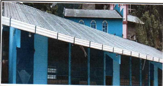
Foto 5: Finalización de puesto de costaneras y de pescante.
