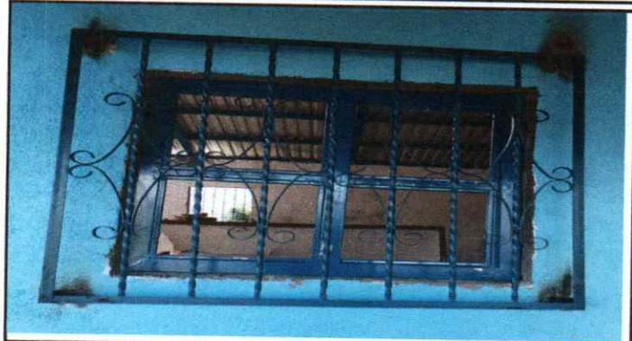
Foto 2: Finalización de cambeo de ventanas de madera
