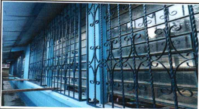
Foto 3: Finalización de cambeos de balcones
