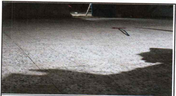
Foto 4: Finalización de cambeos de piso
