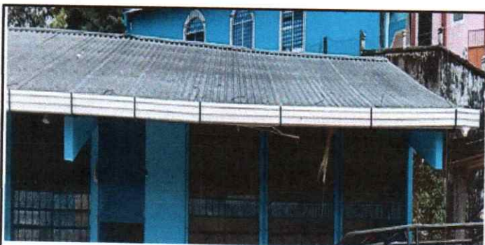
Foto 5: Cambios de costaneras y sustitucion de pescante.
