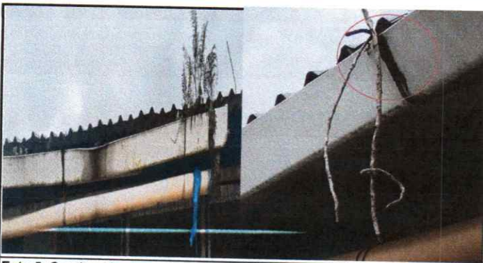
Foto 5: Sustitución de costaneras y sustitucion de pescante.
