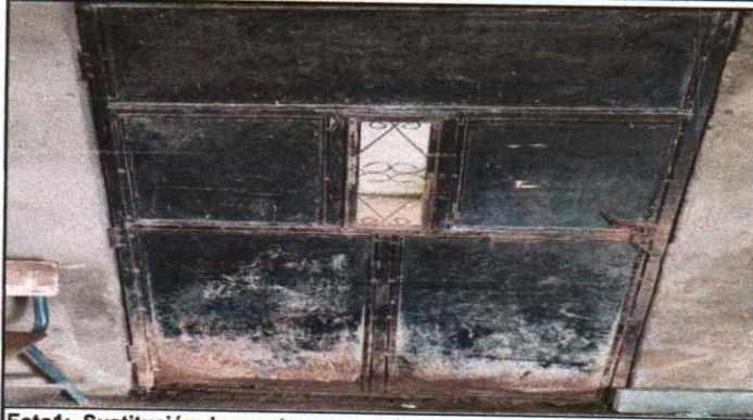
Foto 1: Sustitución de puertas con agujeros.
