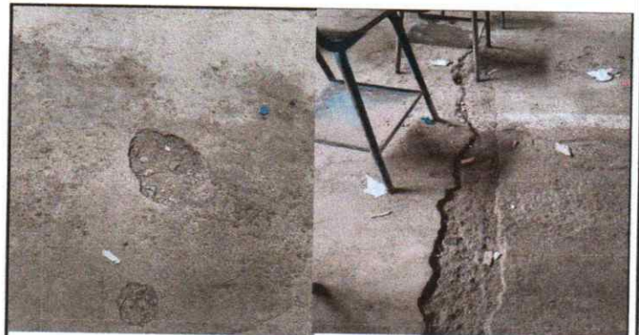
Foto 4: Sustitución de piso
