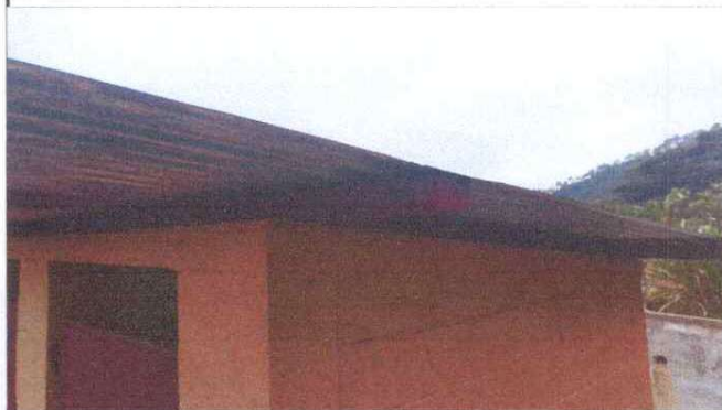
Foto 8: Cambio de techo de madera por metal y lamina troquelada
