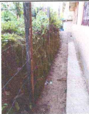
Foto 1: Reparación de tubo hg y malla galvanizada
