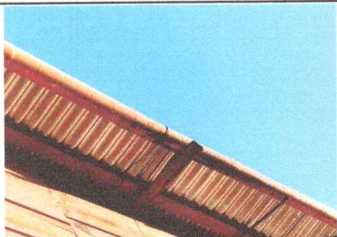
Foto 5: Sustitución de canal de pvc por metal de 6 metros
