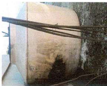
Foto 5: Sustitución de deposito de agua deteriorado
