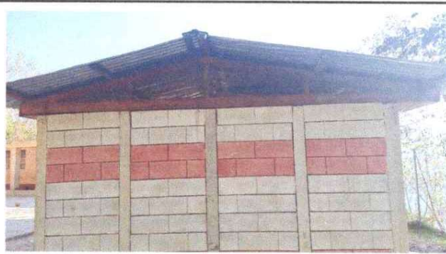
Foto 2: Sustrucción de estructura de madera, por metal
