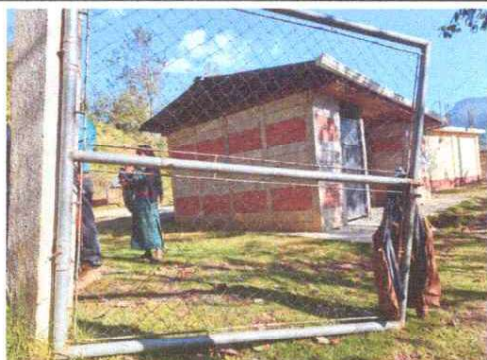
Foto 3: Sustrucción de portón de malla y tubos, por portón de metal
