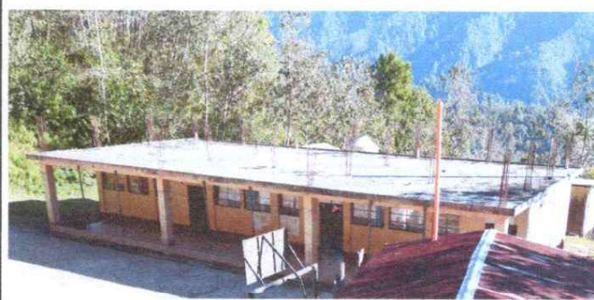
Foto 4: Aplicación de pintura para aulas
