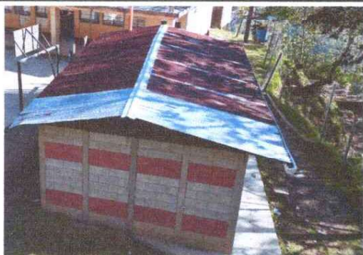
Foto 1: Sustrucción de lámina, por lámina troquelada
