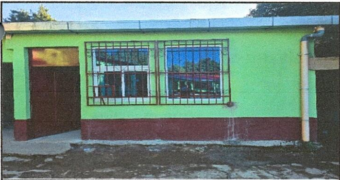
Foto 5: entrega final de balcones.
