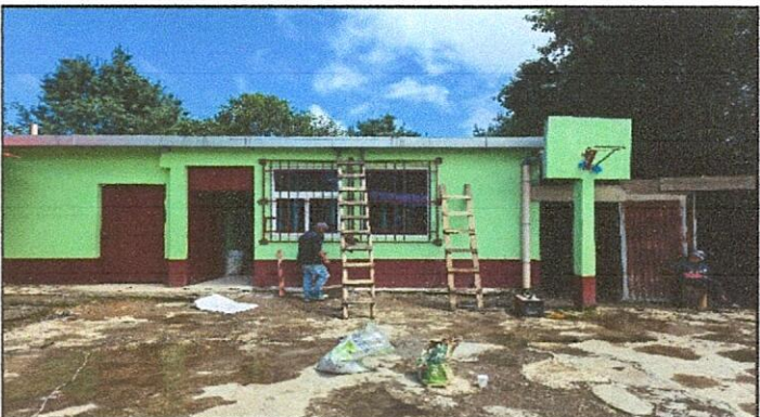
Foto 4: colocación de balcones en la ventana de la cocina.
