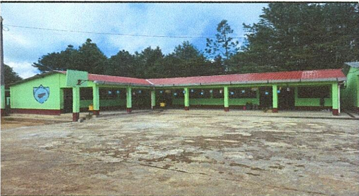
Foto 2: entrega final de cubierta de lámina y estructura de techo.
