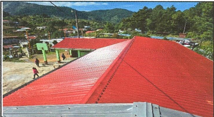
Foto 3: vista panorámica del techo vista desde el lado oriente - poniente.
