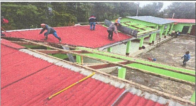
Foto 2: desmontada de techo de aulas y la dirección del centro educativo.
