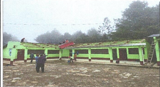
Foto 3: vista panorámica de la escuela ya sin las láminas.
