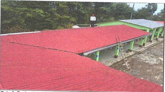
Foto 3: Techo de tres aulas y una dirección vista desde la parte de arriba en escuadra con supervisión de la OPF.
