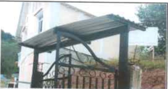
Foto 4: Sustrucción de láminas, por láminas troqueladas aluzinc calibre 26
