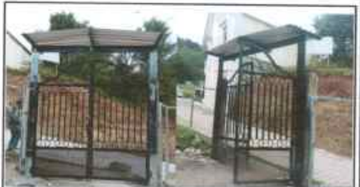
Foto 3: Sustrucción de portón de madera, por portón de metal de 2.55 X 2.50 metros
