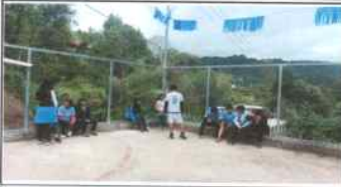
Foto 1.1: Sustrucción de malla galvanizada y tubo hg.
