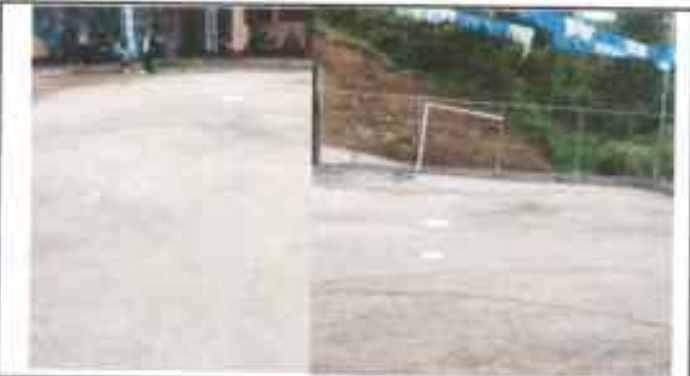
Foto 2: Sustrucción de piso de torta de concreto
