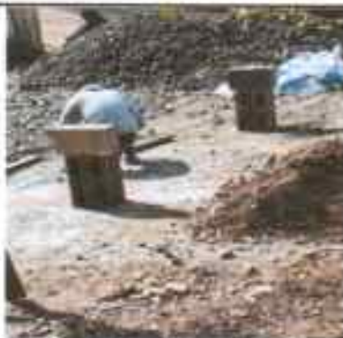
Foto 2: Sustitución de piso de torta de concreto
