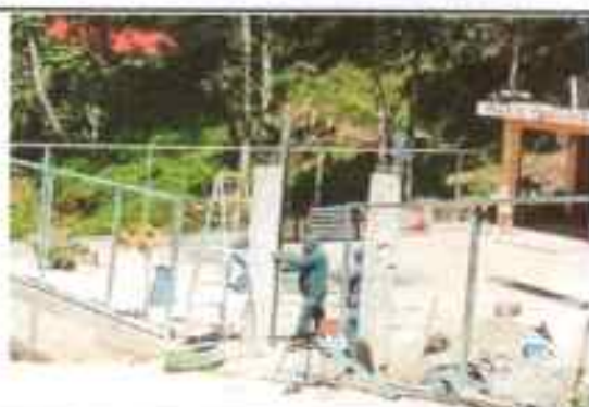
Foto 3: Sustitución de portón de madera, por portón de metal de 2.65 X 2.60 metros
