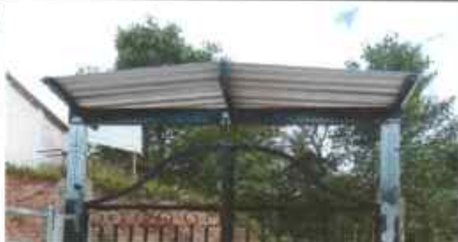
Foto 4: Sustitución de láminas, por láminas troqueladas aluzinc calibre 26
