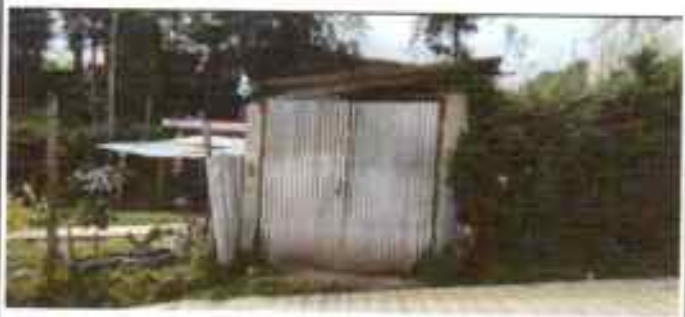
Foto 4: Sustitución de portón de madera, por portón de metal de 2.55 X 2.60 metros
