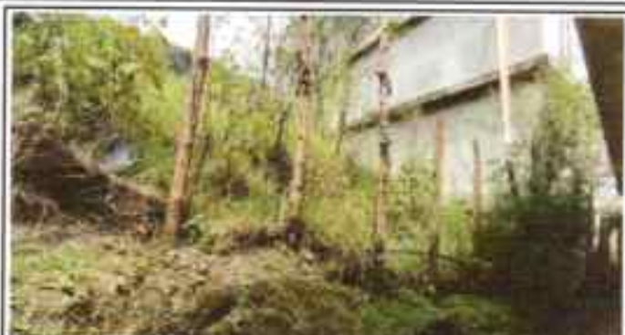
Foto 1.2: Mejoramiento de muro de concreto Y Reparación de tubo hg y Electromalla de 6X6 pulgadas
