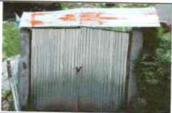
Foto 5: Sustitución de láminas, por láminas troqueladas aluzinc calibre 26
