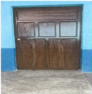
Foto1: Sustitución de puerta de metal (1.00 metros de ancho por 2.10 metros de alto)
