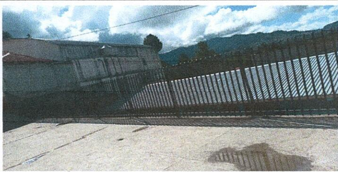
Foto 5: Sustitución de barandas de metal.
