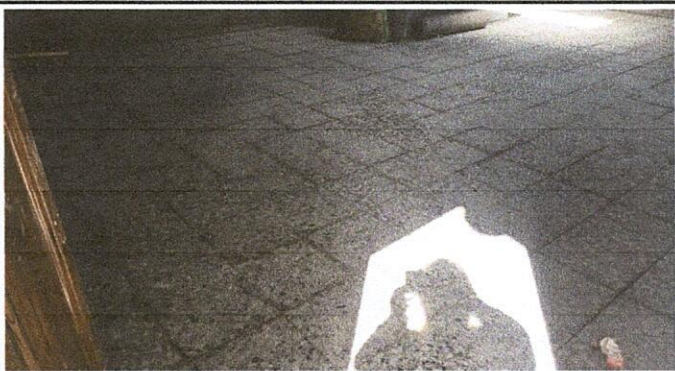
Foto 3: Mejoramiento del piso de granito.
