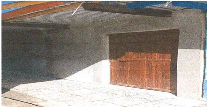
Foto 8: Mano de obra especializada en albañería (instalación de piso de granito)
