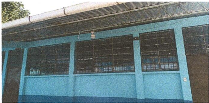
Foto 2: Sustitución de balcones de metal (2.35 metros de alto por 1.52 metros de ancho)
