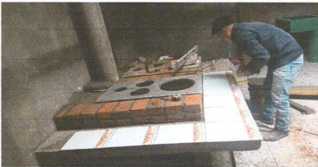
Foto 10: Sustitución de plancha de metal de 3 ornillos
