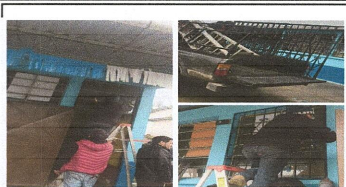
Foto 2: Sustitución de balcones de metal
