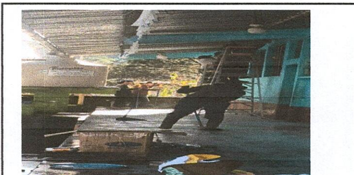
Foto 4: pintura en muros exteriores e interiores.
