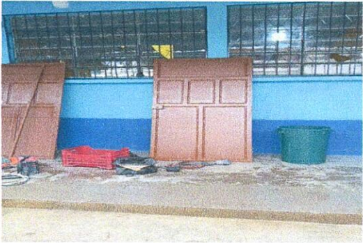
Foto 7: Mantenimiento de estructuras a puertas.
