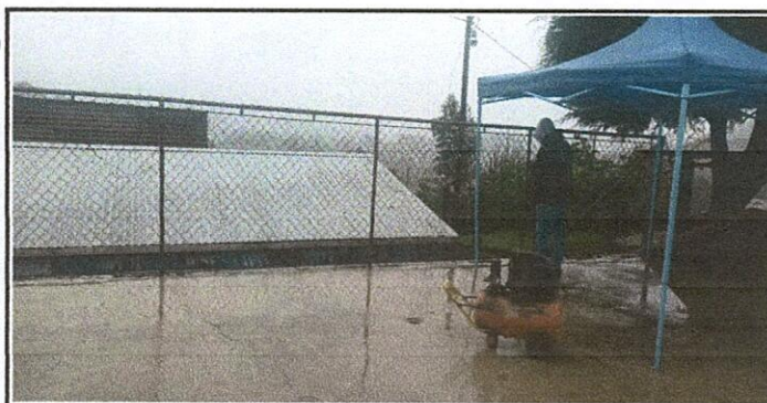
Foto 5: Sustitución de barandas de metal.
