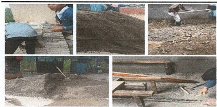
Foto 3: Momento en que se esta trabajando el piso.
