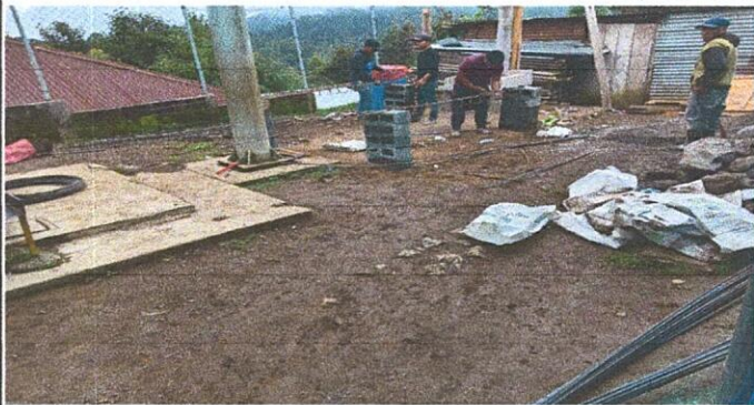
Foto 8: Mano de obra especializada en albañería (instalación de piso de granito)
