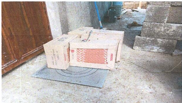
Foto 10: Sustitución de plancha de metal de 3 ornillos
