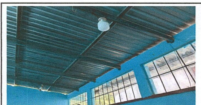
Foto 6: sustitución de focos ahorradores.
