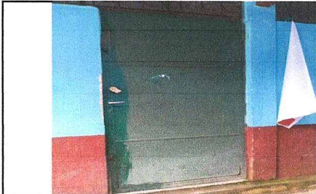
Foto1: Sustitución de puerta de metal (1.00 metros de ancho por 2.10 metros de alto)
