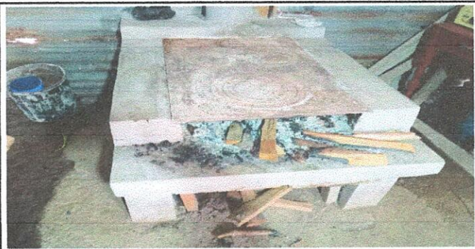
Foto 9: Reparación de azulejo en estufa rural.
