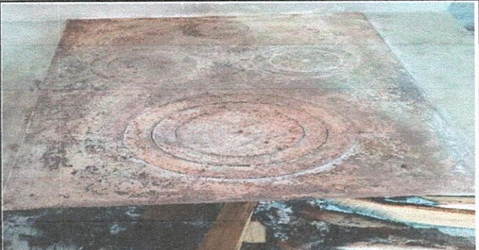
Foto 10: Sustitución de plancha de metal de 3 ornillos
