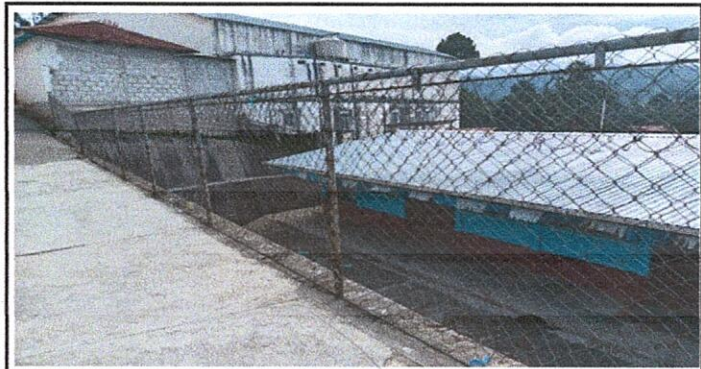
Foto 5: Sustitución de barandas de metal.
