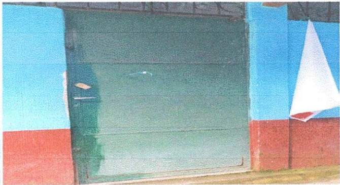
Foto7: Mantenimiento de estructuras a puertas.
