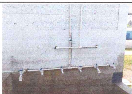
Foto 4: Instalación de nueva tubería de lavamanos
