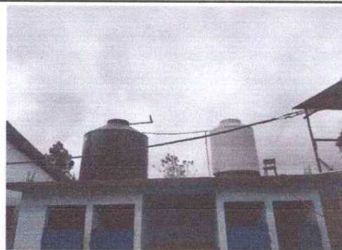
Foto 2: Instalación de rotoplas y Instalación de entechado de rotoplas
