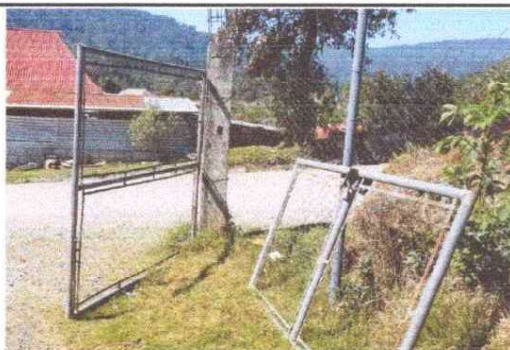
Foto 6: Mantenimiento a estructura
