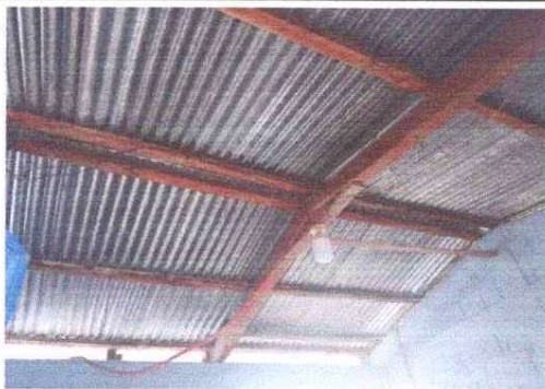
Foto 1: Sustitución de techo y estructura
