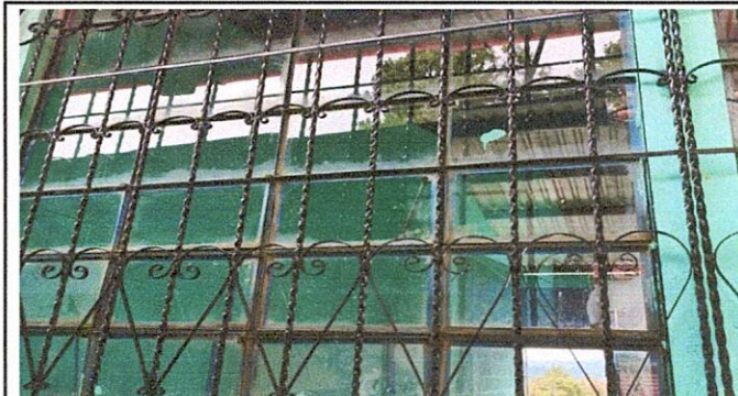
3.1 sustitución de vidrios transparente de 5mm de grosor
