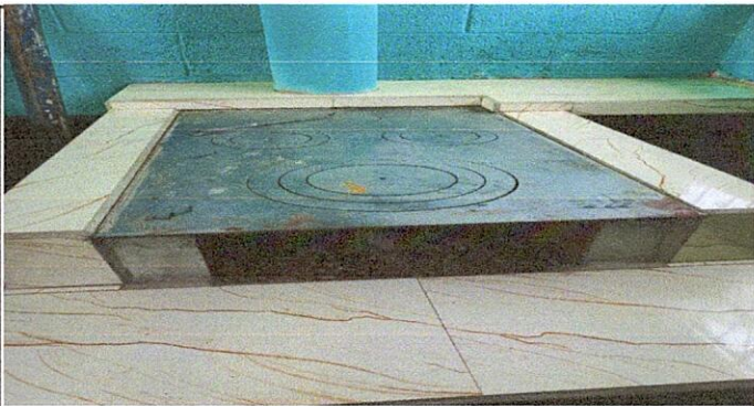
8.1 sustitucion de plancha de mental de 3 ornillas
