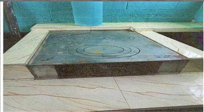
10.1 sustitucion de azulejo de plancha
