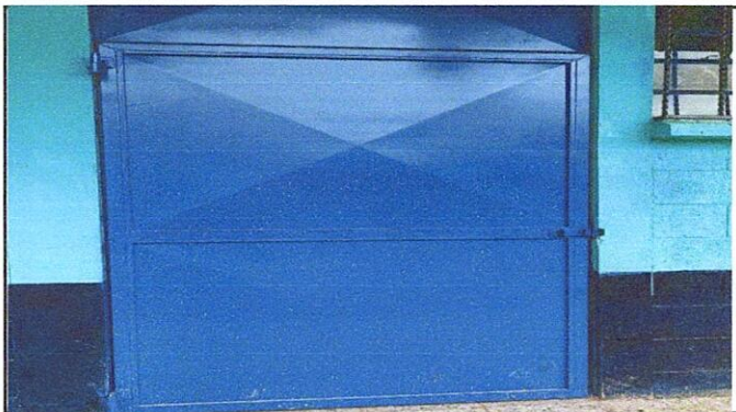
Foto 2.1 mantenimiento de estructura (lijado y aplicación de pintura en puertas metal
