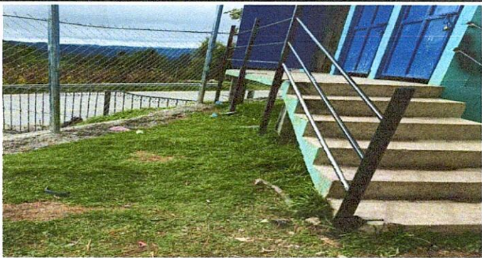
7.1: mantenimientos de barandas de servicio sanitario
