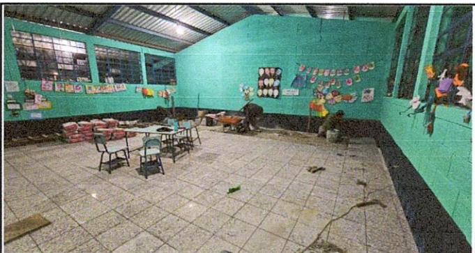
Foto 4: 1 sustitucion de piso de concreto por cerámica
