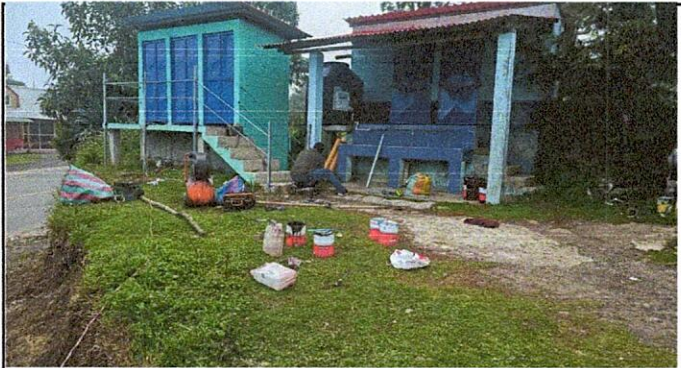
Foto: 5.1 mantenimiento a estructura (lijado, sepillado, aplicación de pintura color nebgro anticorrosivo a puertas de servicios sanitarios
