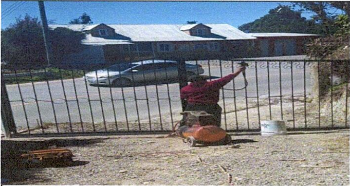
2.2 mantenimiento de portón de metal con las medidas de 250 x 350
