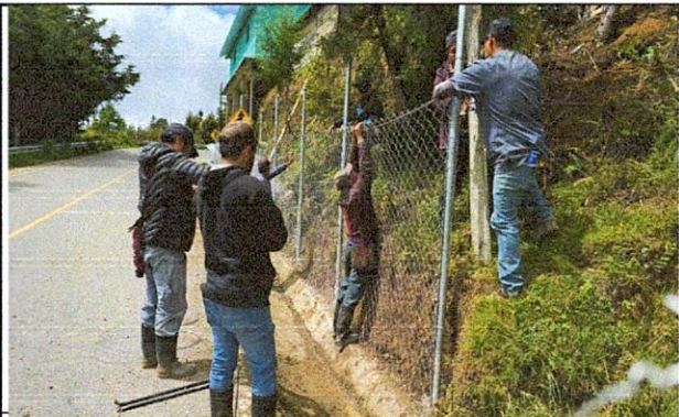
6.1 reparación de tubos de concreto por tubo galvanizada y malla galvanizada
