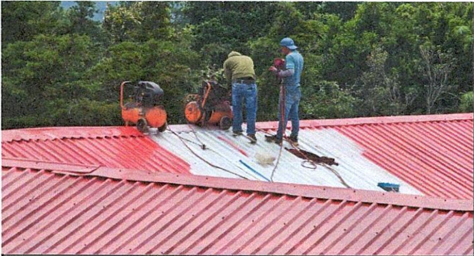
Foto 1. 1: mantenimiento y aplicación de pintura en estructura de soporte de metal y techo de lamina troquelada.
