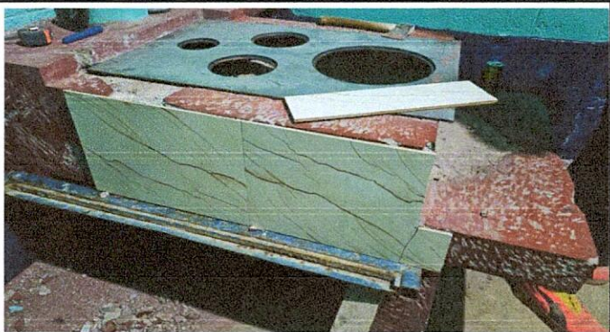
8.1 sustitucion de plancha de mental de 3 ornillas
