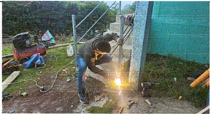
7.1: mantenimientos de barandas de servicio sanitario
