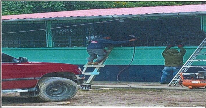
3.2 mantenimiento a balcones de metal lijado y aplicación de pintura
